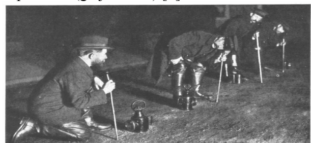
Slika 5: 1900, prve akustične naprave za detekcijo vodnih izpuh.
