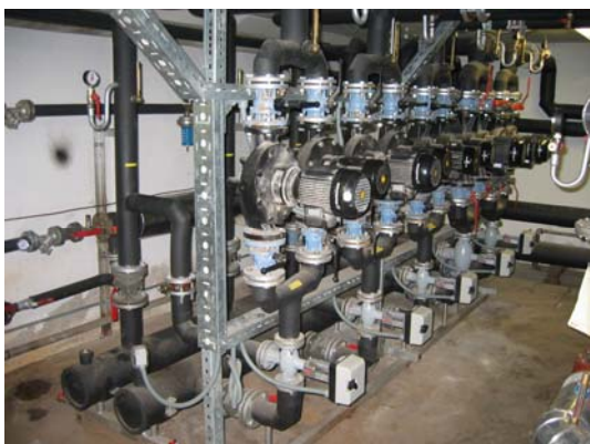
Slika 5: Sekundarni ogrevalni razvod v TPPC
